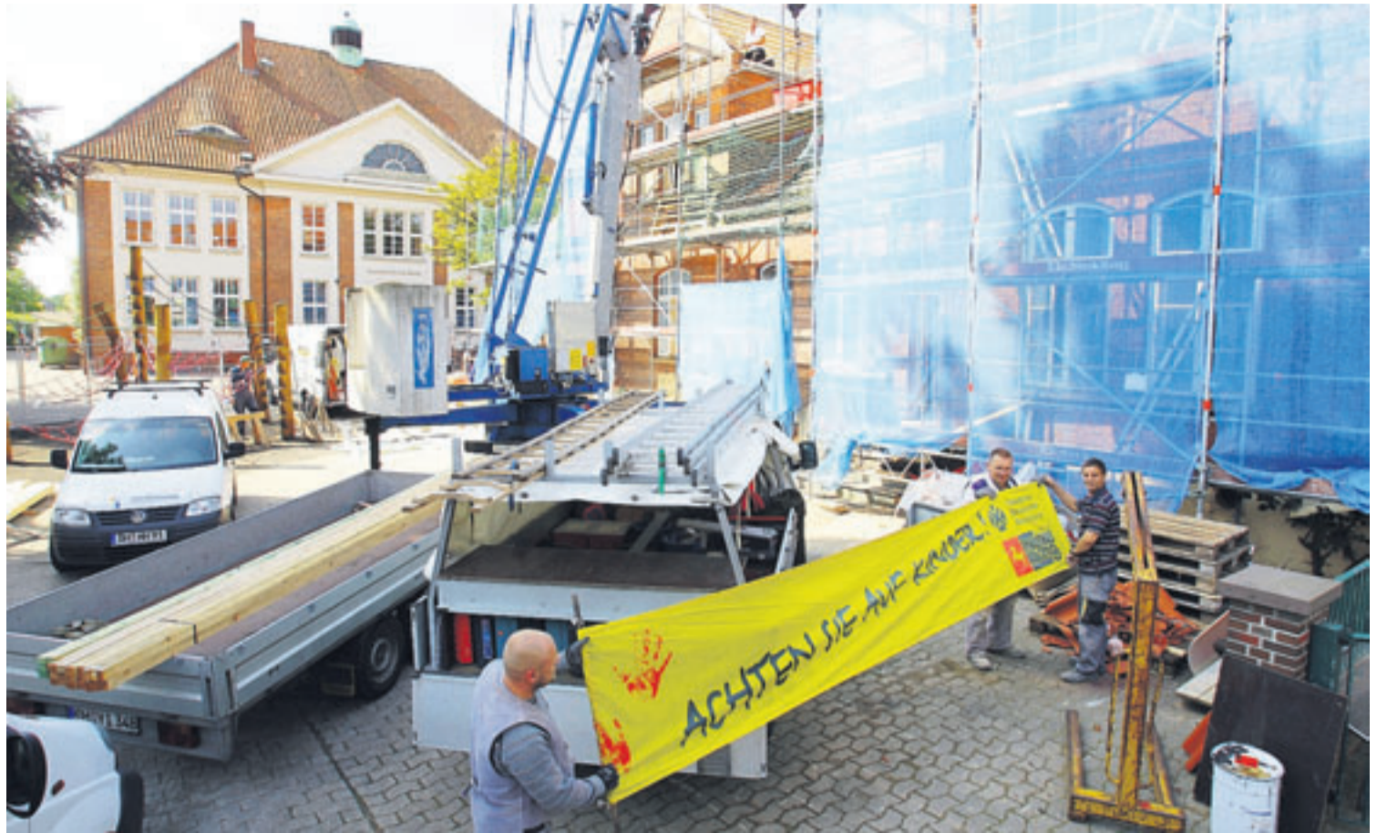
An der Grundschule Am Markt werden zurzeit zwei neue Unterrichtsräume hergerichtet.
